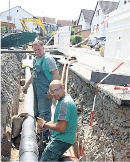
Seit einigen Monaten sind die Arbeiten am Nahwärmenetz in Erfurthausen in vollem Gange. Archivfoto: Florian Lerchbacher
