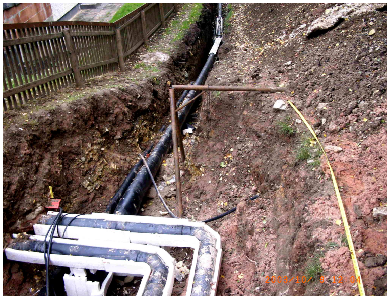
Rohrverlegung im Graben
