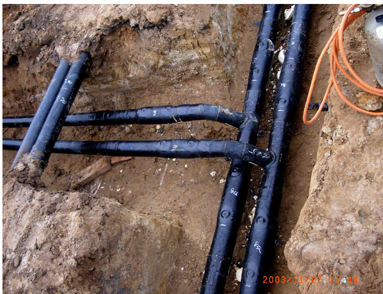
Rohrverlegung zum Hausanschluss mit KMR
